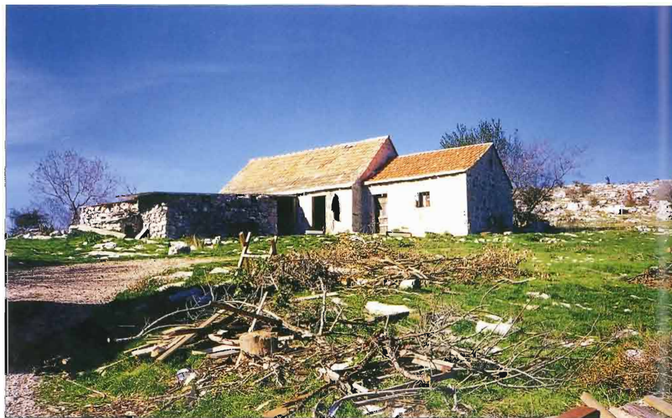
48 Gospodarske zgrade: kužina, pojata, natkriveni tor, gnojnica – rpa, Jukića staje, Vrdovo Outbuildings and structures: kitchen, byre, covered fold, dunghill – rpa, Jukića staje, Vrdovo
