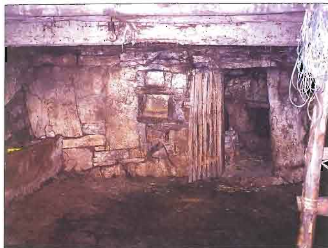
63 Štala i trap u kući 3, Đapići, Vrdovo Byre and root cellar in house 3, Đapići, Vrdovo
