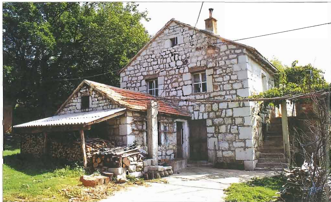
9 Kuća 2 – stambena katnica i uz nju prizemnica s kominom
